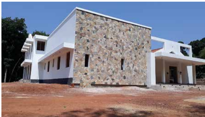
Casa de las HH. Terciarias Capuchinas en construcción
